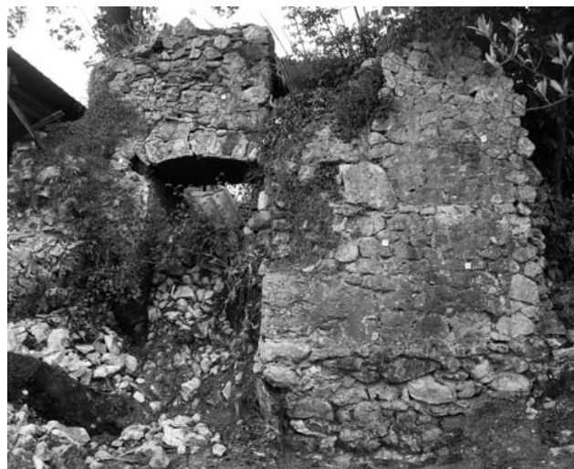
Fig. 4. Strutture in opera incerta.
